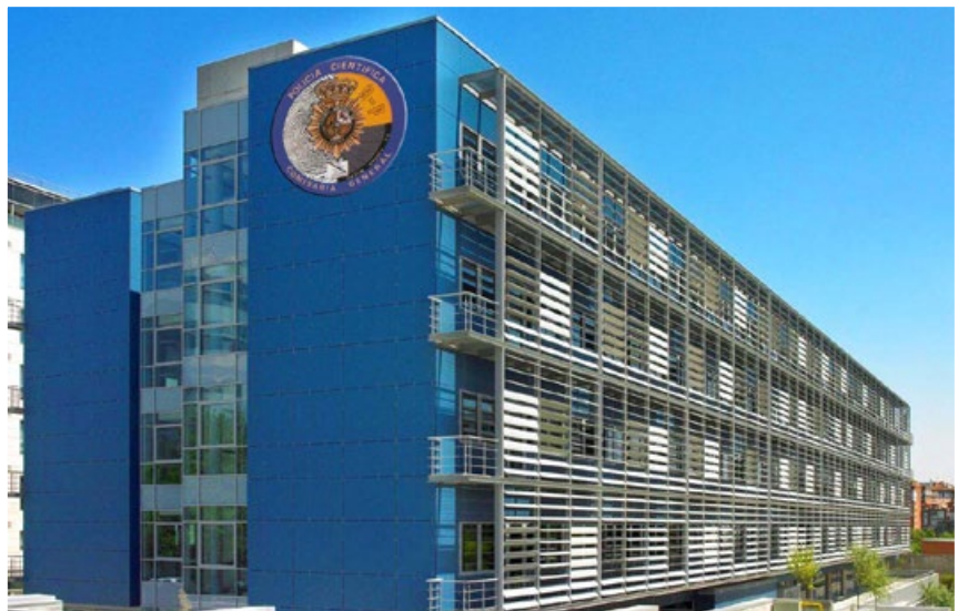
Edificio central de Policía Científica en el complejo policial de Canillas, Madrid
