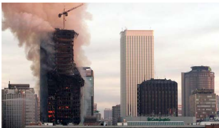
En la imagen, la Torre Windsor de Madrid en llamas. El edificio fue destruido por un gran incendio el 12 de febrero de 2000. Tenía 106 metros de altura y 32 plantas. Estaba situado en pleno centro financiero de la ciudad, en la zona de AZCA.
